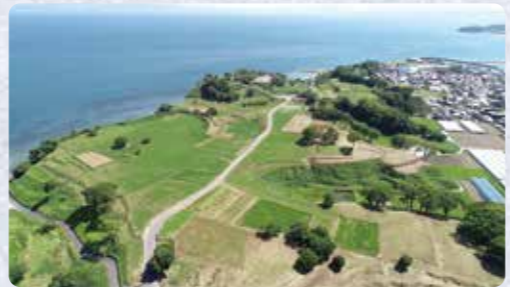
豪雨により、二ノ丸跡では多くの崩落が見つかりました
