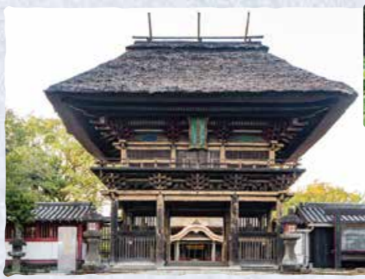
急な勾配が特徴の葺き屋根の楼門
