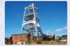
現存する日本最古の鋼鉄製槽（宮原坑）
