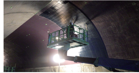
炭素繊維シート貼付
