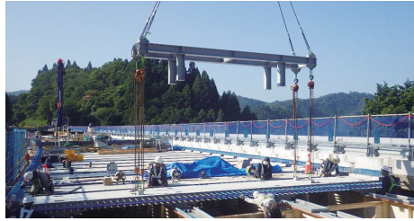
プレストレストコンクリート床版架設
