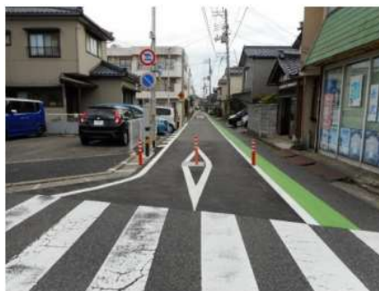
写真：新潟県新潟市日和山小学校 (平成 30 年 4 月本格導入) (ソフトライジングボラード)
