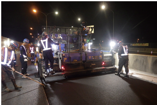
《舗装工事(イメージ)》
